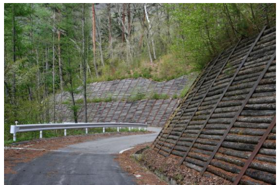
写真-11 木製法面保護工
