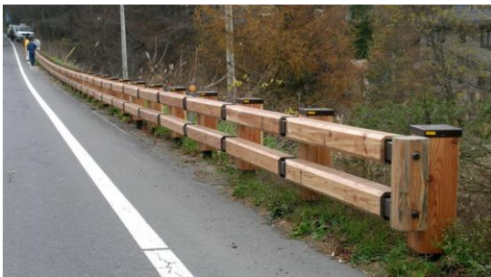
写真-12 信州型木製ガードレール3号型(上)と同2号型(下, 中軽井沢)
