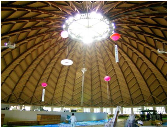
写真－6 やまびこドームの外観と内部
