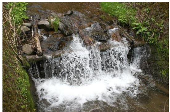
写真－9 丸太法砕工、木製修景工、木工沈床
