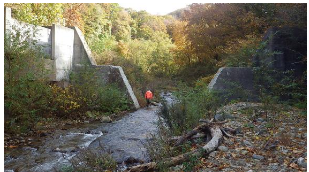
写真 38 スリット化した治山えん堤（スリット形状：底面幅 3m、側壁 5 分勾配の台形断面）
