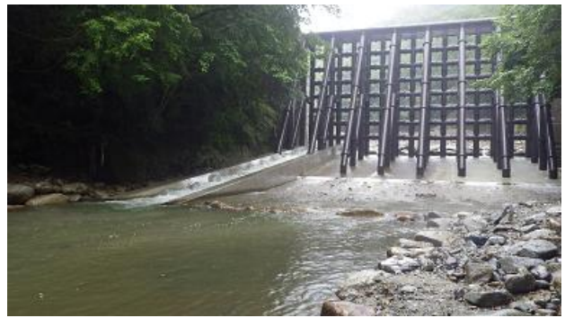
写真 32 鋼製えん堤の右岸側に魚道が設置された事例
