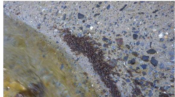
写真 26 台形断面魚道の斜めの側壁の水際に沿って溯上する横エビ
