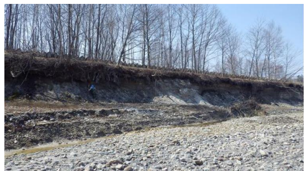
写真5 高水敷の樹林化および低水路内の平坦箇所の砂礫の堆積によって生じた河床低下
