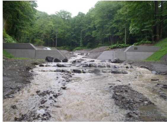
写真 44 スリットえん堤下流側の流況
