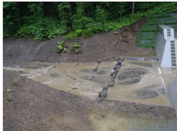
写真 45 掘り込み型減勢工と連続帯工
