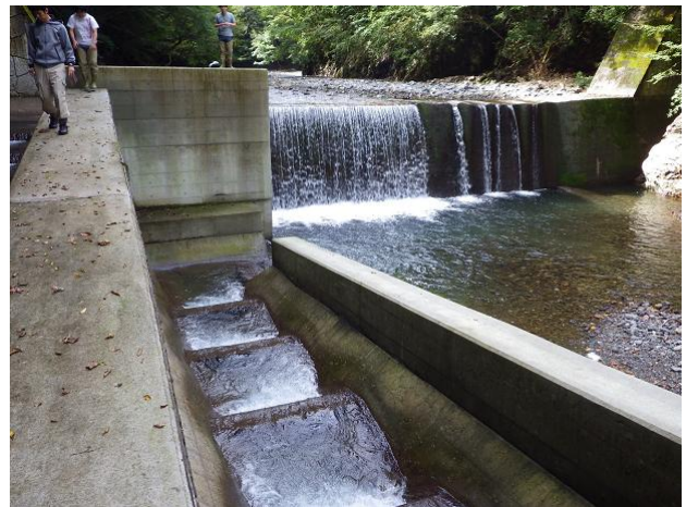
写真 30 魚道からの流量よりえん堤からの流量の方が大きい場合
