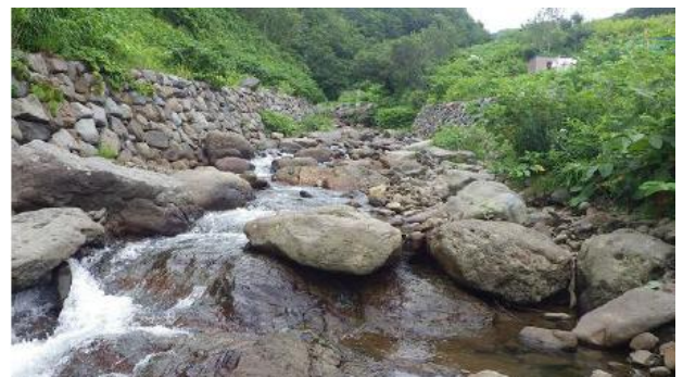
写真4 中小洪水流の通水断面が確保されていないことによって生じた河床低下
