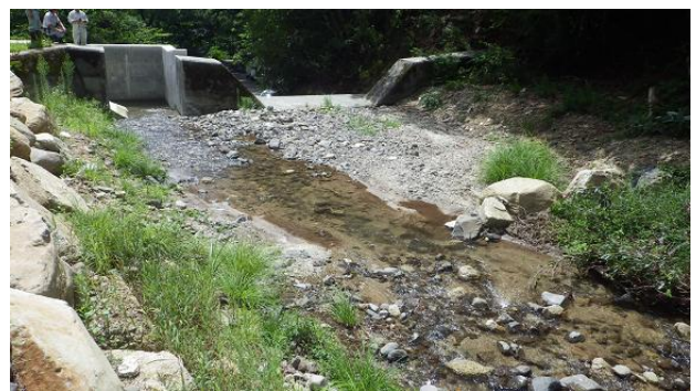
写真 50 巨礫の水制工を用いた滲筋の制御
