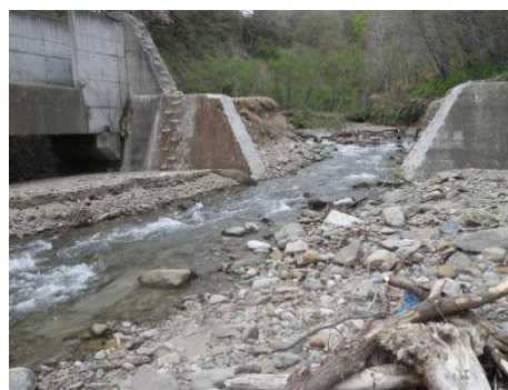
写真 39 スリット化が完了した翌年の河道の状況（写真 38 の場合と同じ場所）
