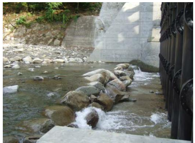
写真 34 鋼製えん堤上流側の河道を整形した状態
