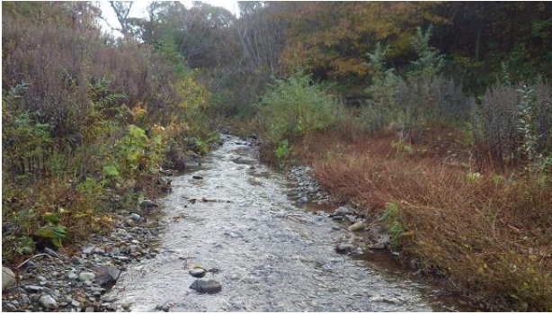
写真 40 スリット化された治山えん堤上流側の河道の状態（堆積土砂があった直線部）
