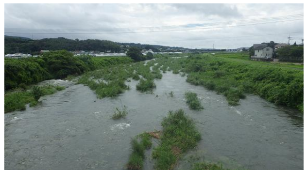
写真 16 河道内に繁茂した植生に出水時の流れが冠水した状態
