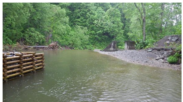
写真 48 木製枠の水制工を用いた滲筋の制御
