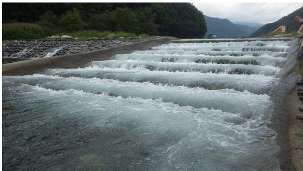
写真 25 施工竣工から 6 年経過後の状態
