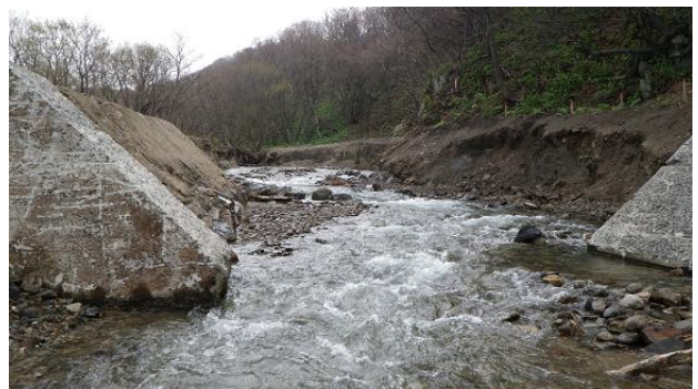
写真 37 スリット化が完了した翌年の河道の状況（写真 36 の場合と同じ場所）
