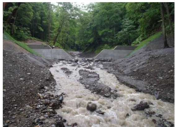
写真 46 えん堤下流側の流況（小規模洪水）
