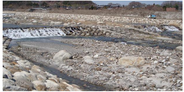
写真 20 魚道（中央部）を伴う床固め工からの流れの状態
