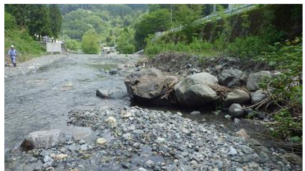
写真 49 魚道流入部付近の巨礫の水制を用いた滲筋の制御
