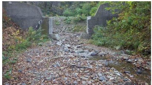
写真 41 複断面型スリット化した治山えん堤（スリット形状：下部は底面幅 2m、高さ 1m、側壁 5 分勾配の台形断面であり、上部は 5m 幅の矩形断面）
