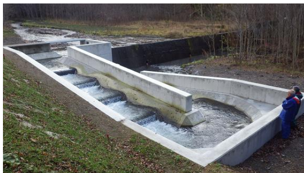
写真 23 治山えん堤に設置された折り返し型プール式台形断面魚道
