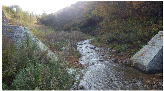
写真 36 スリット化した治山えん堤（スリット形状：底面幅 3m、側壁 1 割勾配の台形断面）
