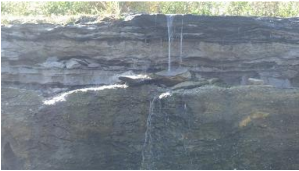
写真 6 河床低下に伴い地下水が滝のように流れている様子（河川の水温調整機能を失った状態）
