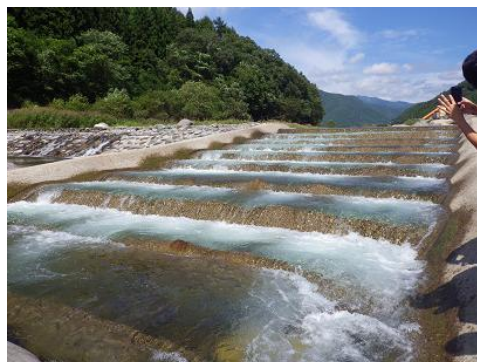
写真 24 片品川の砂防施設に整備された台形断面
