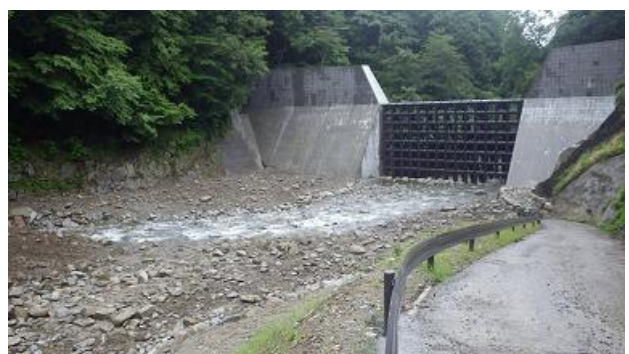
写真 35 鋼製えん堤上流側の河道の様子
