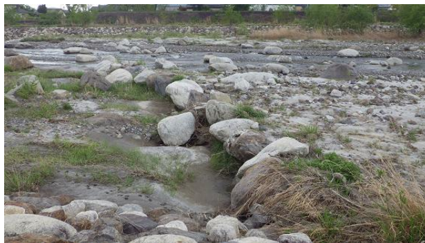
写真 21 滯筋の流路を固定するための水制工
