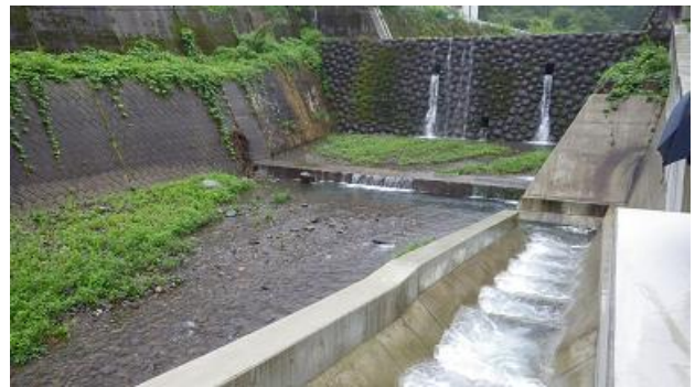
写真 31 魚道からの流量の方がえん堤からの流量が大きい場合
