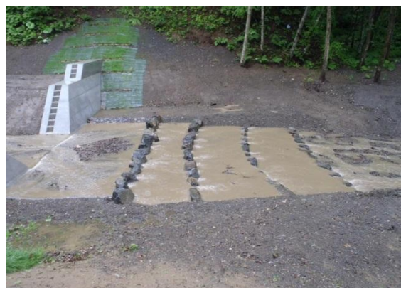
写真 47 掘り込み型減勢工および帯工群
