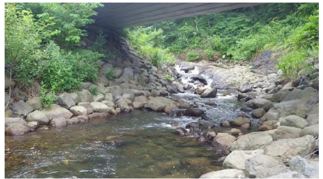
写真3 橋脚の過剰な保護によって河道が狭くなって生じた河床低下
