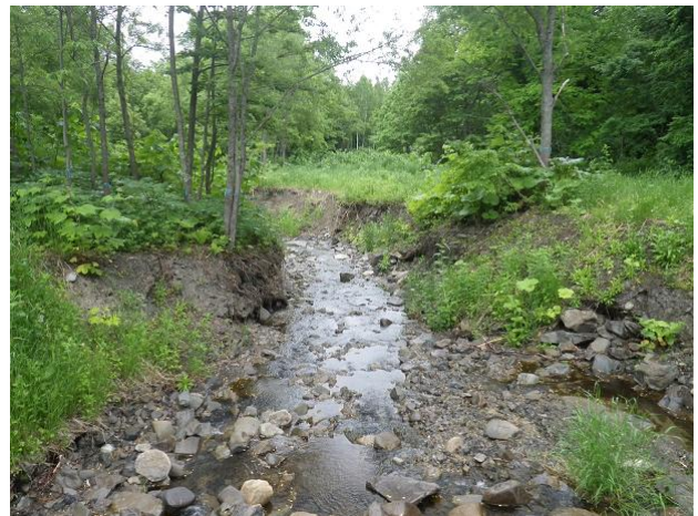
写真 10 河床低下および河岸侵食した蛇行部
