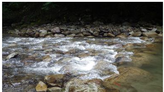
写真 33 減勢池下流側の河川への接続状況
