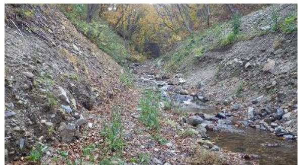
写真 43 スリットえん堤間の河道の状態
