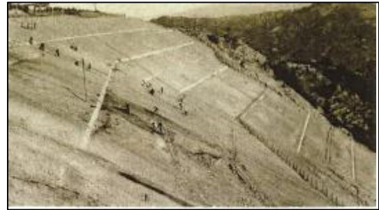
図 13 上部排土のり面の緑化工 3)
