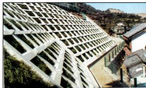
図19 アンカー付法枠工 25)
