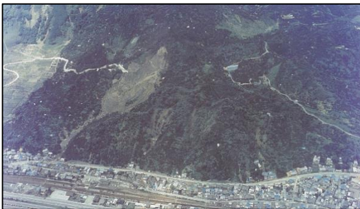
図14 濁沢の土石流災害(昭和49年) 25)
