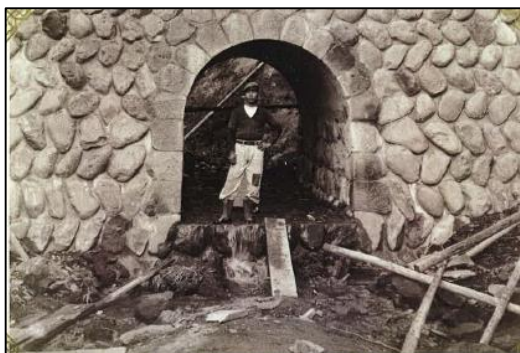
写真3 濁沢の治山堰堤（アーチ型水抜） 1)
