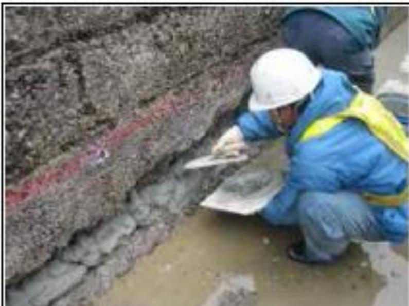
写真 4. 2. 1-1 断面修復材の充填
