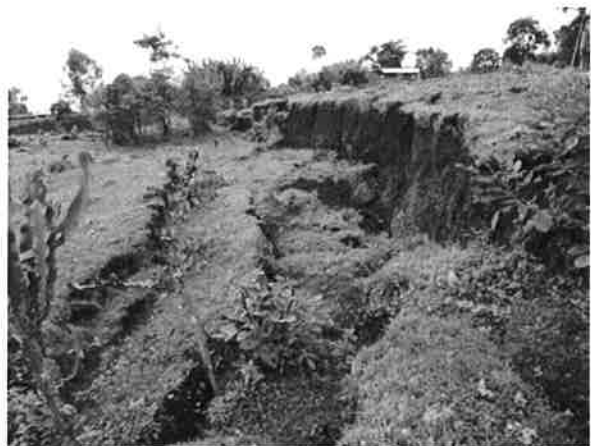
写真11 Bonga近郊で発生した地すべり
