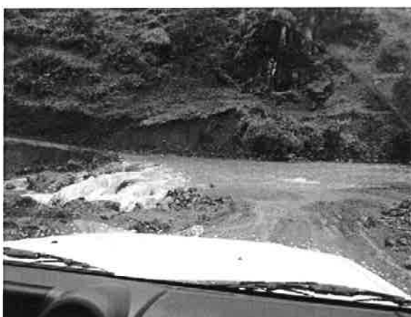
写真5 河川により寸断された地方道路
