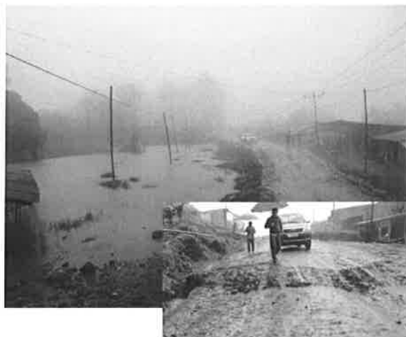
写真14 道路脇の畑の湛水で発生したChida近郊の地すべり
