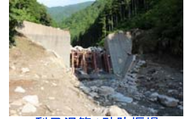
梨子沢第1砂防堰堤
