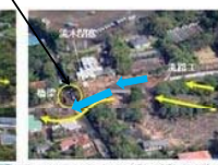
写真-2-14 つばき宇初海岸の橋梁の流木閉塞状 況 (撮影:株式会社バスコムシステム株式会社,撮影日:)
