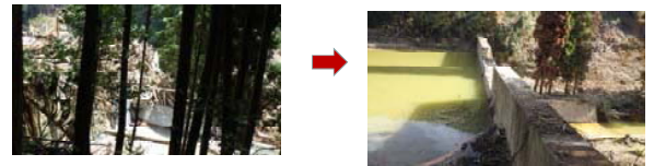
流木捕捉状況 (堆砂地) → 流木除去後 (堆砂地) 土砂は未満砂であった。
