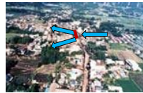
写真-1 古慮川における流木による 橋梁の閉塞に伴う土石流・流木 の氾濫・堆積状況
