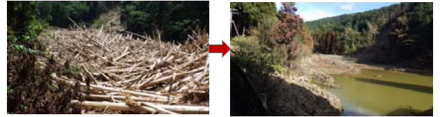
流木捕捉状況 (堆砂地) → 流木除去後 (堆砂地) 土砂は未満砂であった。
