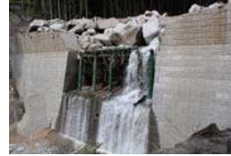
梨子沢第2砂防堰堤
