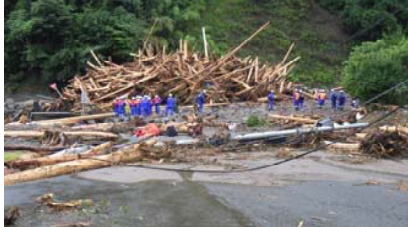
流木による閉塞された橋梁（平成29年7月北九州豪雨、福岡県東峰村、大肥川支川宝珠山川）
