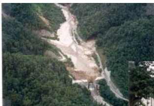
↑砂防堰堤による 流木・土砂の捕捉
