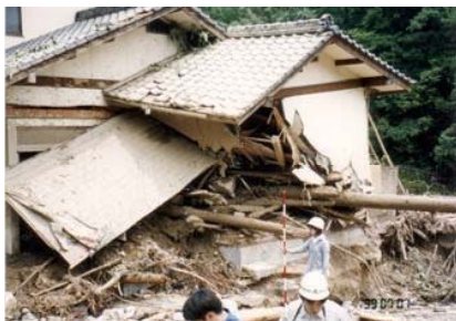
流木災害の例 (1999年6月広島災害、古野川)
