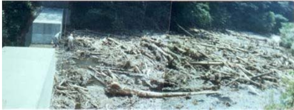
• 広島県加計町 江河内東谷、1988年7月 流木除去中
