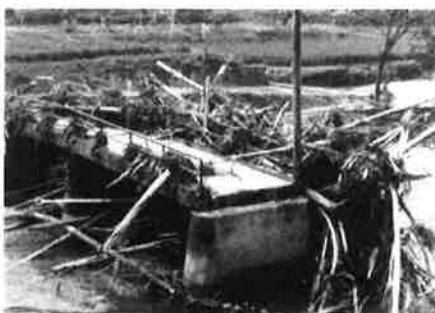
写真-3 1986年京都府南部災害における流木による白砂川の西奥橋の閉塞と流出
