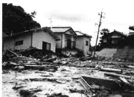
写真-2 1999年広島災害における荒谷川での流木による橋梁の閉塞と土石流の氾濫
