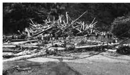
写真-1 2017年九州北部豪雨による大肥川支川宝珠山川における流木による橋梁の閉塞と洪水の氾濫
