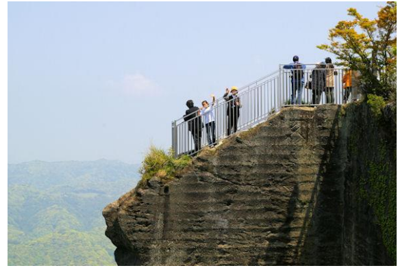
写真6 展望台に設置された転落防止柵
