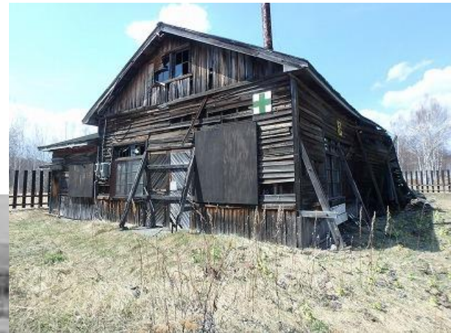
音更森林鉄道修理庫
