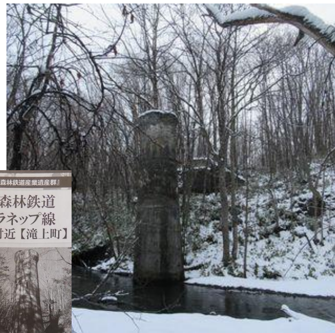
森林鉄道橋脚遺構
