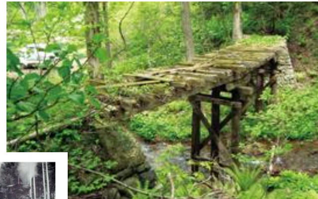
小泊海岸森林鉄道片狩刈石支線ヒバ橋梁
