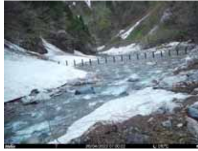
流木捕捉状況 （定点カメラ:上流） 令和4年4月26日 7:00
