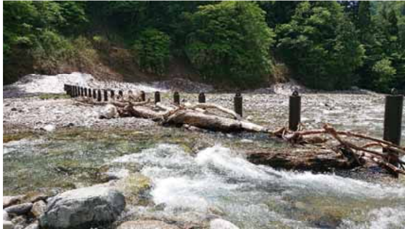
流木捕捉状況 （カメラ:左岸上流より） 令和4年5月30日
