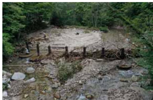
令和3年9月（ドローンカメラ：下流側より）
