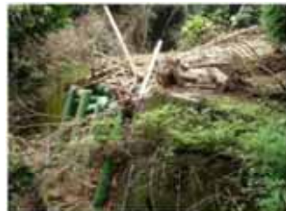
池山施設(透過型池山ダム)の流木捕獲状況(佐田地区)
