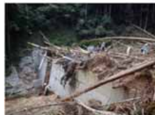
池山施設(不透透型の池山ダム)の流木捕獲状況(藤城地区)
