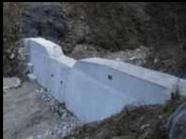
遮水型の治山ダム
