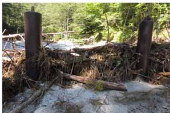
令和3年9月10日（地上カメラ：下流側より）
