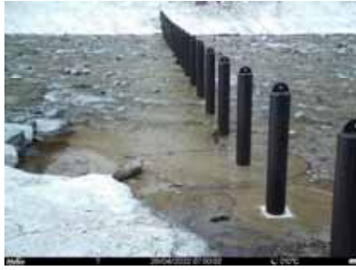
流木捕捉状況 （定点カメラ:左岸） 令和4年4月26日 7:00
