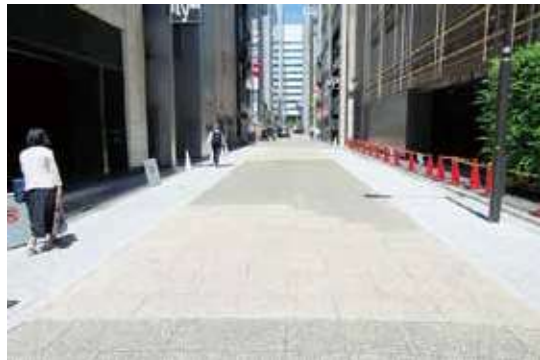
写真11 歩車道の境が弱い(銀座あづま通り)
