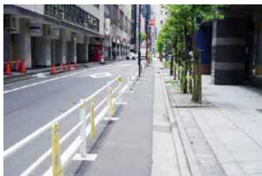
写真12 横断防止柵の設置状況(銀座)
