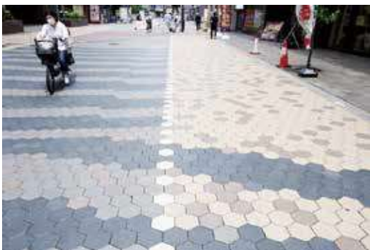
写真14 歩車道の境を弱くしている（浅草）
